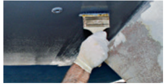
High Protect met een kwast in tegengestelde richting opbrengen
