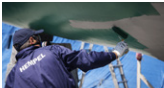
Antifouling opbrengen over primer of hechtverbeteraar
