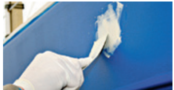
Einzelne Stellen mit Spachtelmesser bearbeiten
